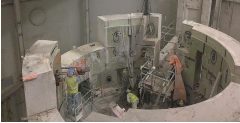
Şekil 11: Elmas tel ile kesme işlemi
