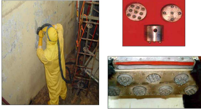
Şekil 10: Beton taşlama işlemi
