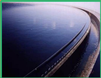
Atıksu son dinlendirme havuzu
