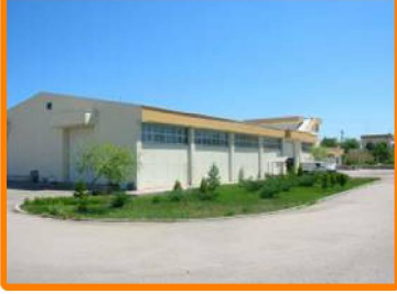
Gama Işınlama Tesisi
