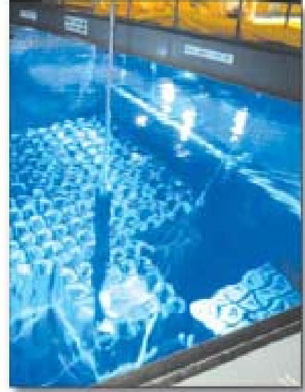
Kullanılmış Yakıt Depolama Havuzu
