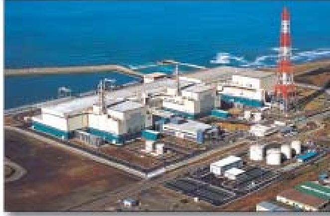
Şekil 7.5. Japonya'daki Kashiwazaki-Kariwa Nükleer Güç Santrali
