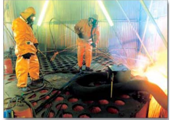
Windscale Gaz Soğutmalı Güç Reaktöründe Üst Biyolojik Zırhın Sökülmesi
